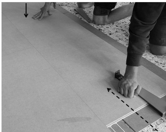
Placer l'appui du tire-lame contre le bord de la plaque inférieure pour ne pas endommager le système d'assemblage. Pour un emboîtement parfait, il peut être utile d'appliquer un appui au niveau de la jonctions de 2 panneaux de la ligne précédemment assemblée.
