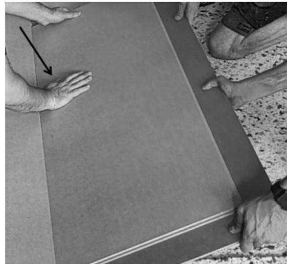
En cas de difficulté d'emboîtement, vérifier que le système clic « fold / down » n'est pas endommagé ou encombré.
